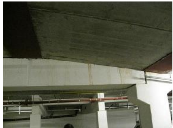
Overgang imellem rampe og væg -1
