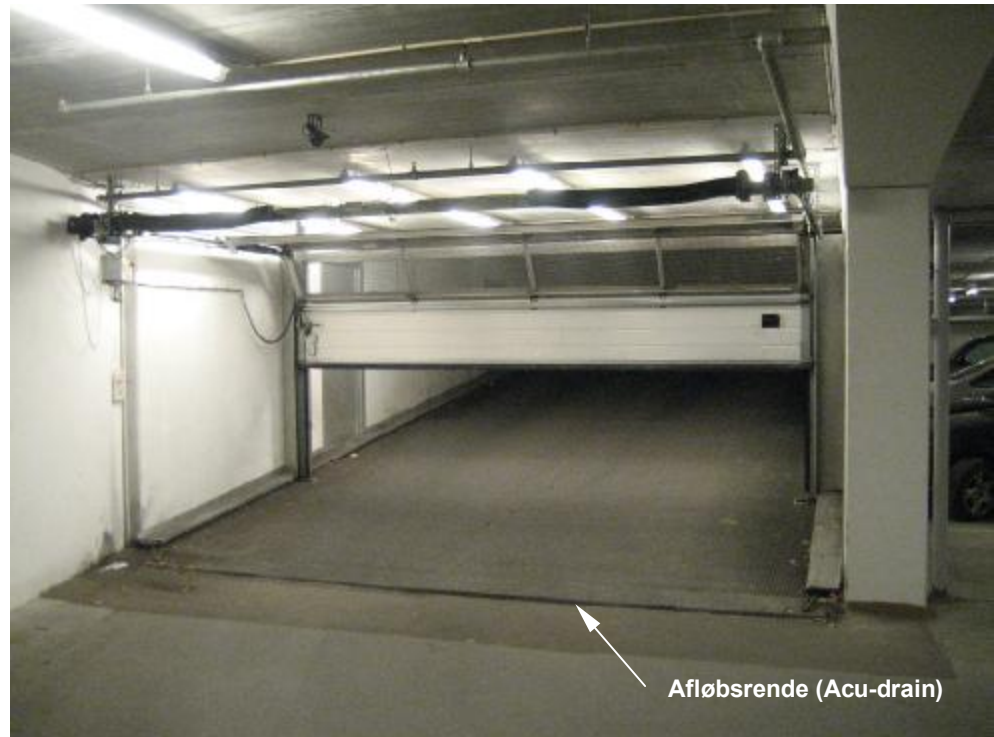
Port til P-kælder – åbning - set inde fra P-kælder
