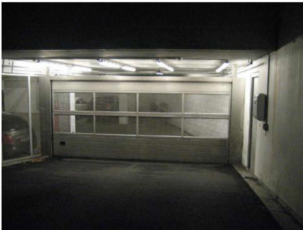
Port til P-kælder – set ude fra rampen
