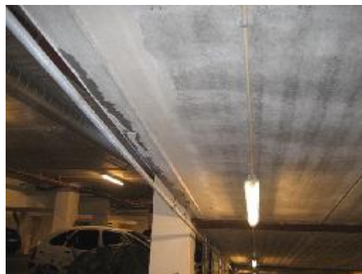
Synlig vandindtrængen – mod fri kant
