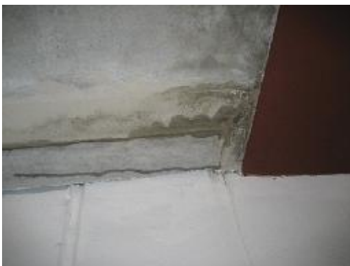
Synlig vandindtrængen – mod væg
