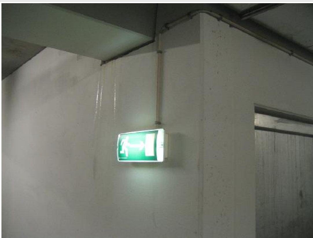
Synlig vandindtrængen på indv. side af væg om trappeskakt
