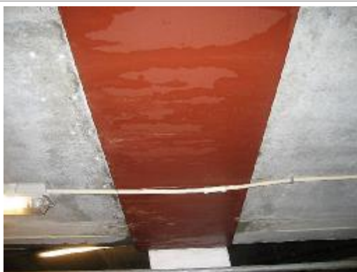
Synligt vandspor på bærejern
