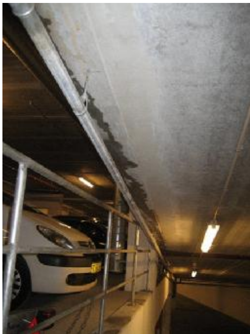
Synlig vandindtrængen ved rampens frie kant
