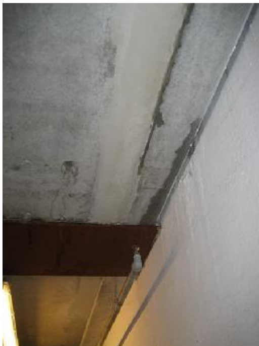
Synlig vandindtrængen mod væg - vand på tværgående bærejern
