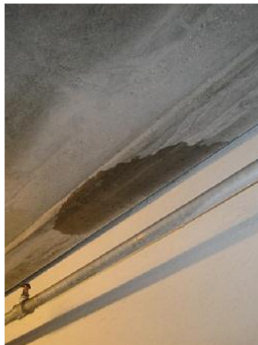
Synlig vandindtrængen mod væg
