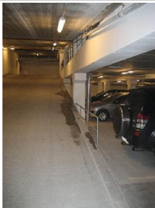
Synlige fugtpletter på rampe mod P-dæk 2
