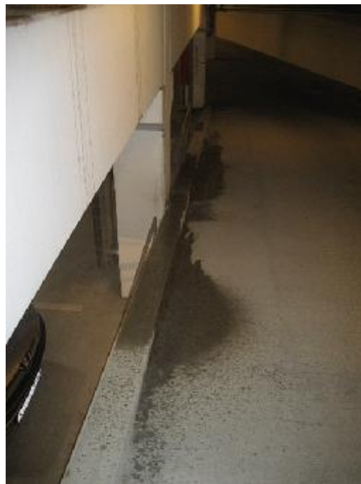
Synlige fugtpletter på rampe mod P-dæk 2
