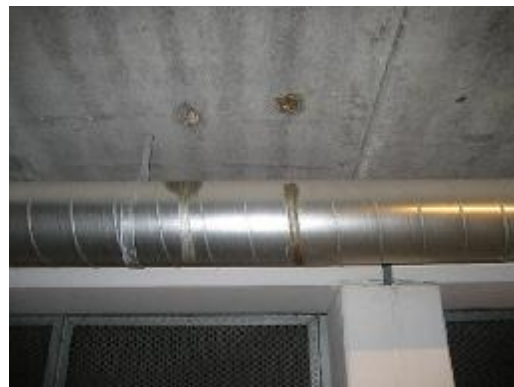
Vandindtrængen direkte gennem dæk og begyndende korrosion af ventilationsrør
