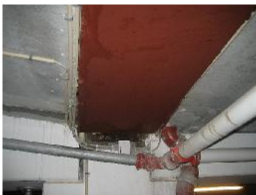
Synligt vandspor på bærejern ved slut af rampe ved P-dæk 2
