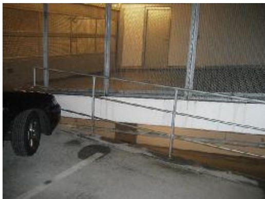
Vandindtrængen gennem afskærmning med strækmetal
