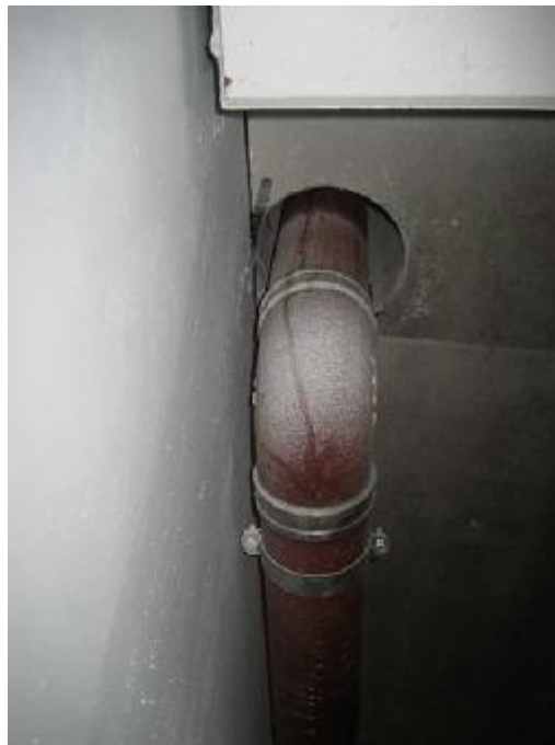
Synligt vand på nedløbsrør
