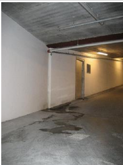
Synligt vand på dæk udfor dør på P-dæk 2
