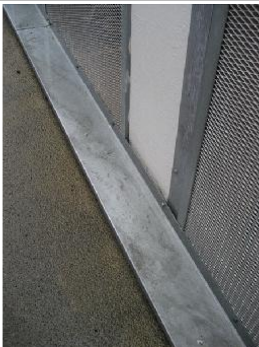
Åbent bag inddækning udfor søjler
