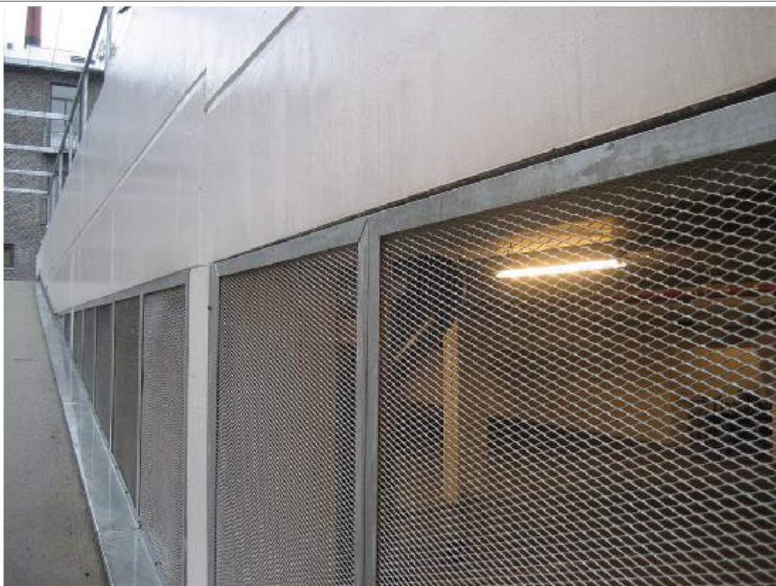
Slagregn fra opkant over ramme med strækmetal løber ned og ind over rammerne.
