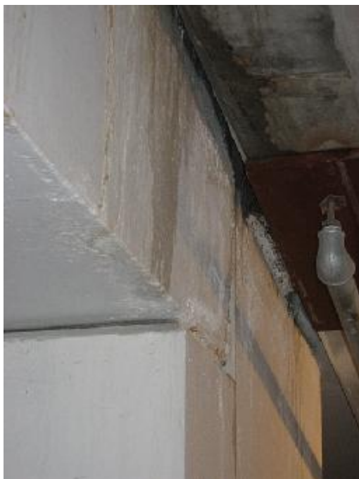
Synlig vandindtrængning før øverste tværliggende bærejern
