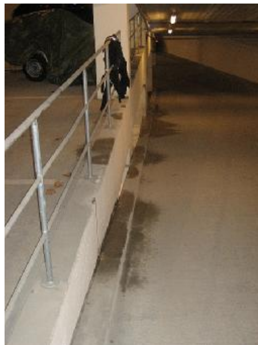
Synlig vandindtrængning på rampe mellem P-dæk 1 og 2
