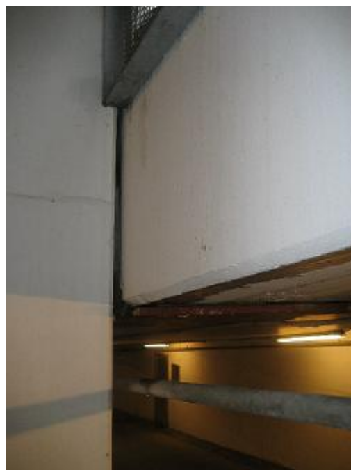
Synlig vandindtrængning ved rampe
