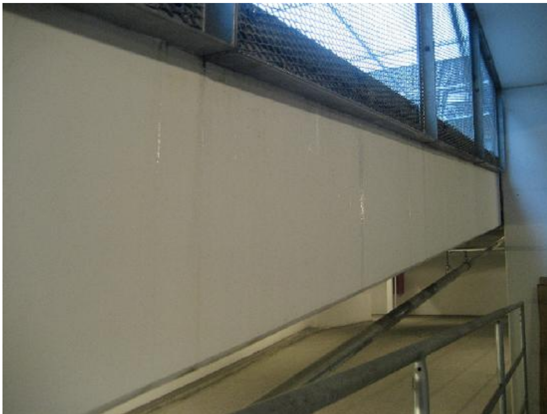
Synlig vandindtrængning mellem ramme og rampekant
