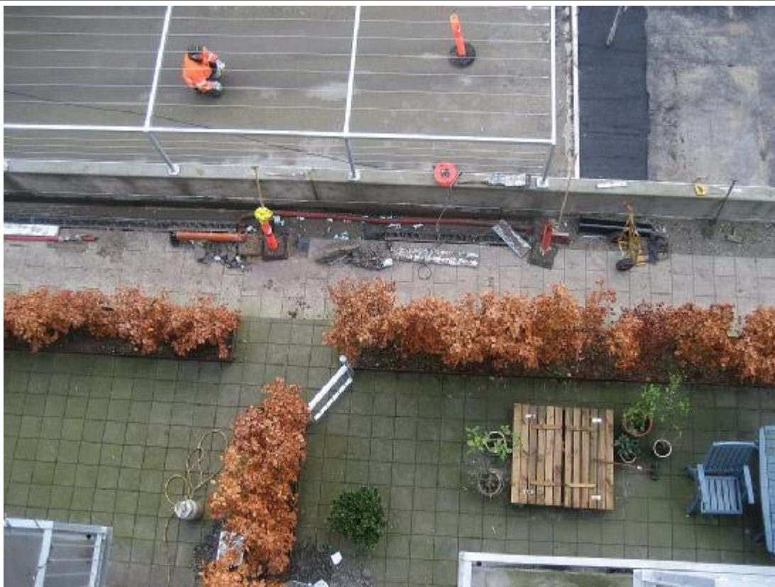
Opgravning mellem rampekant og vandrende opstartet – foto af 10.12.2008
