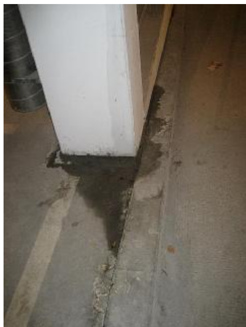
Fugtplet på betondæk ved søjlefod
