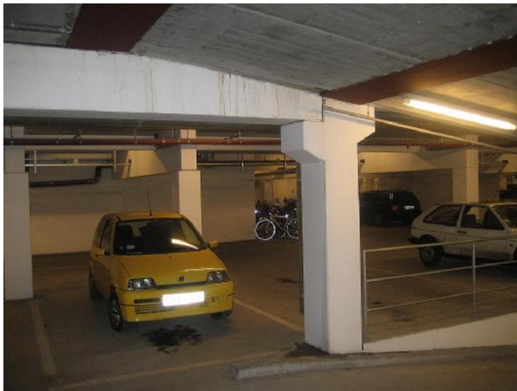
Rampe – P-dæk 1 – ved rampe til dæk -2
