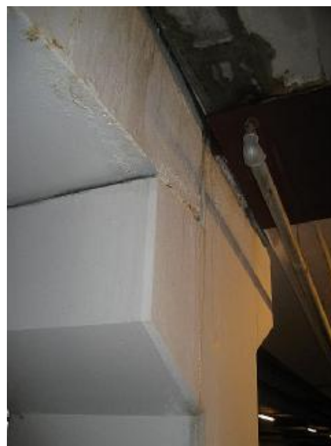
Synlige vanddråber ved underkant drager
