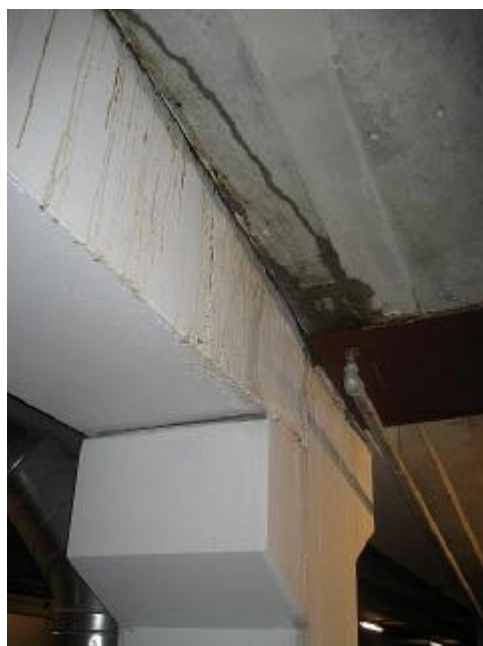
Synlige spor af indtrængende regnvand ved loft
