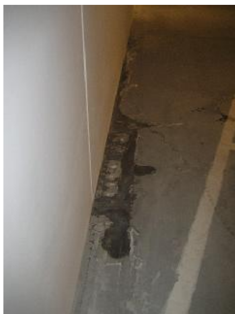
Fugtpletter ved dæk
