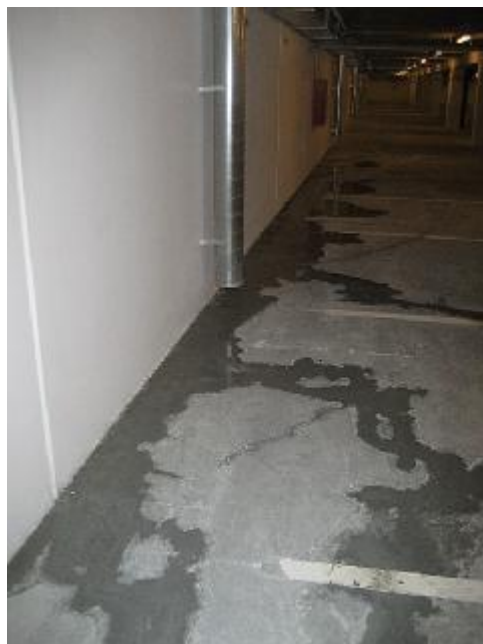
Stående vand i pytter langs ydervæg
