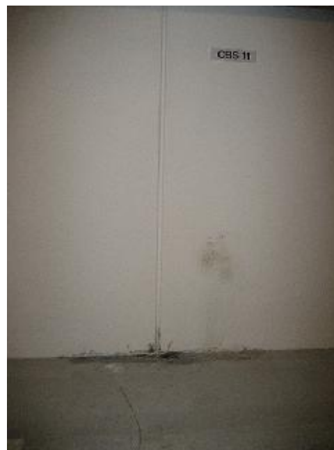
Fugtpletter ved dæk
