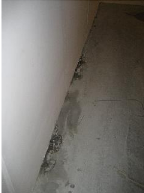
Fugtpletter ved dæk
