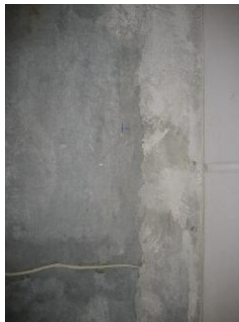
Synlig ikke-udfyldt langsgående revne (Tværgående revne er nylig udfyldt)
