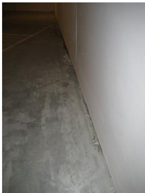
Fugtpletter ved dæk
