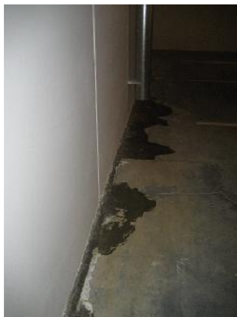
Stående vand i pytter langs ydervæg
