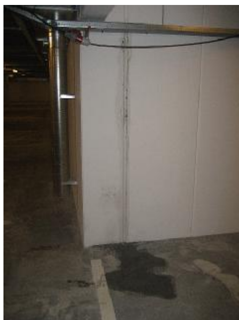
Fugtpletter ved dæk – Synlig spor på væg
