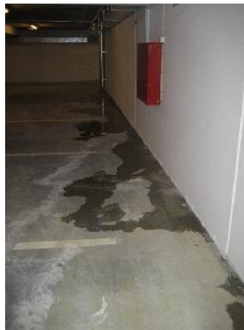
Stående vand i pytter langs ydervæg
