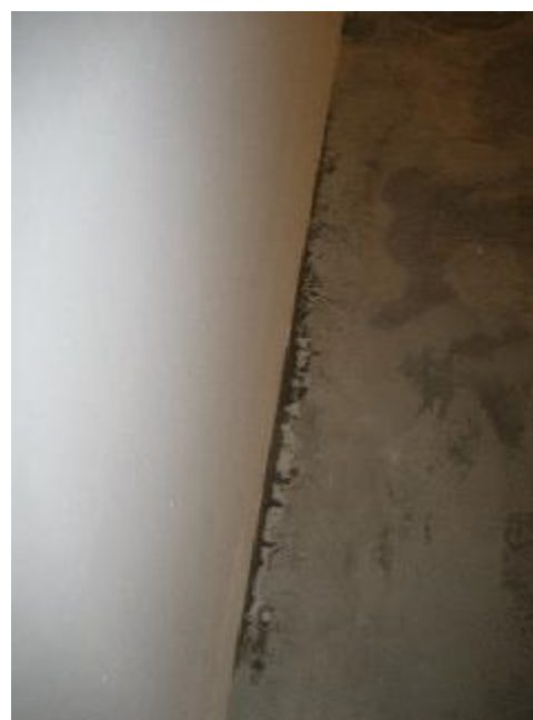
Fugtpletter ved dæk
