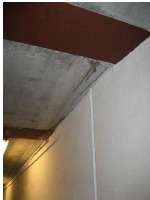
Rampe ved loft
