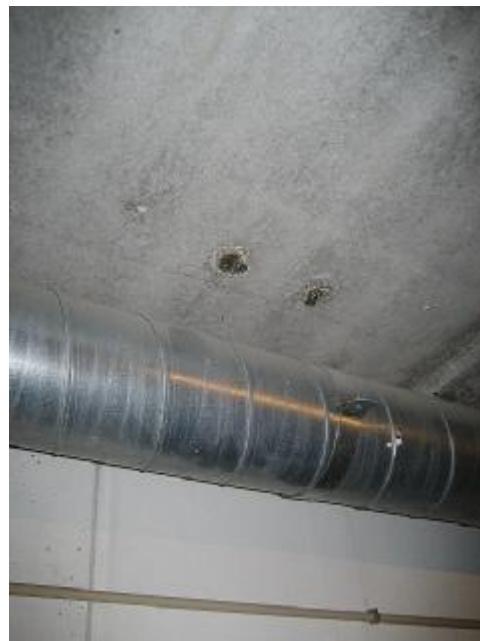
Vanddryp fra huller i loft
