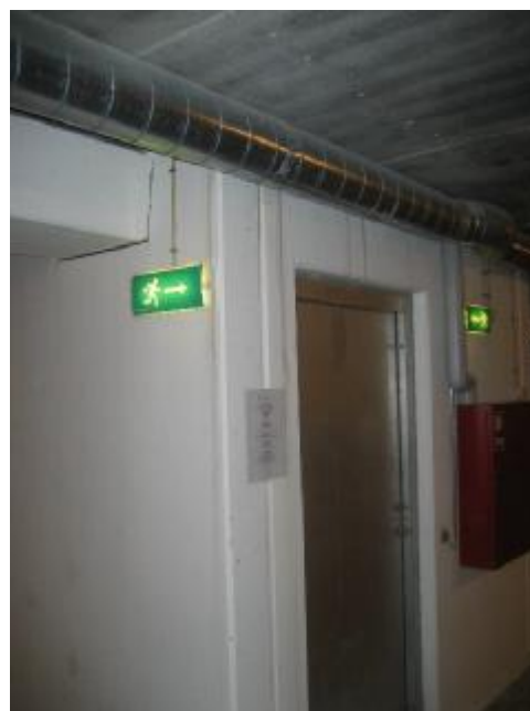
Løbende vand på indvendig side af væg
