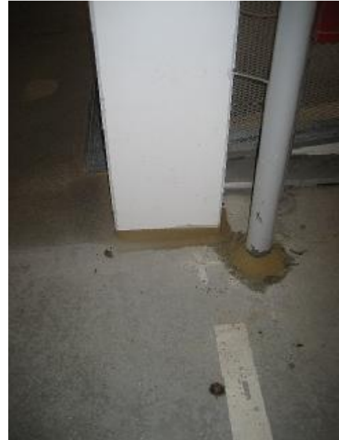
Epoxy behandling omkring betonsøjle og rørinstallation
