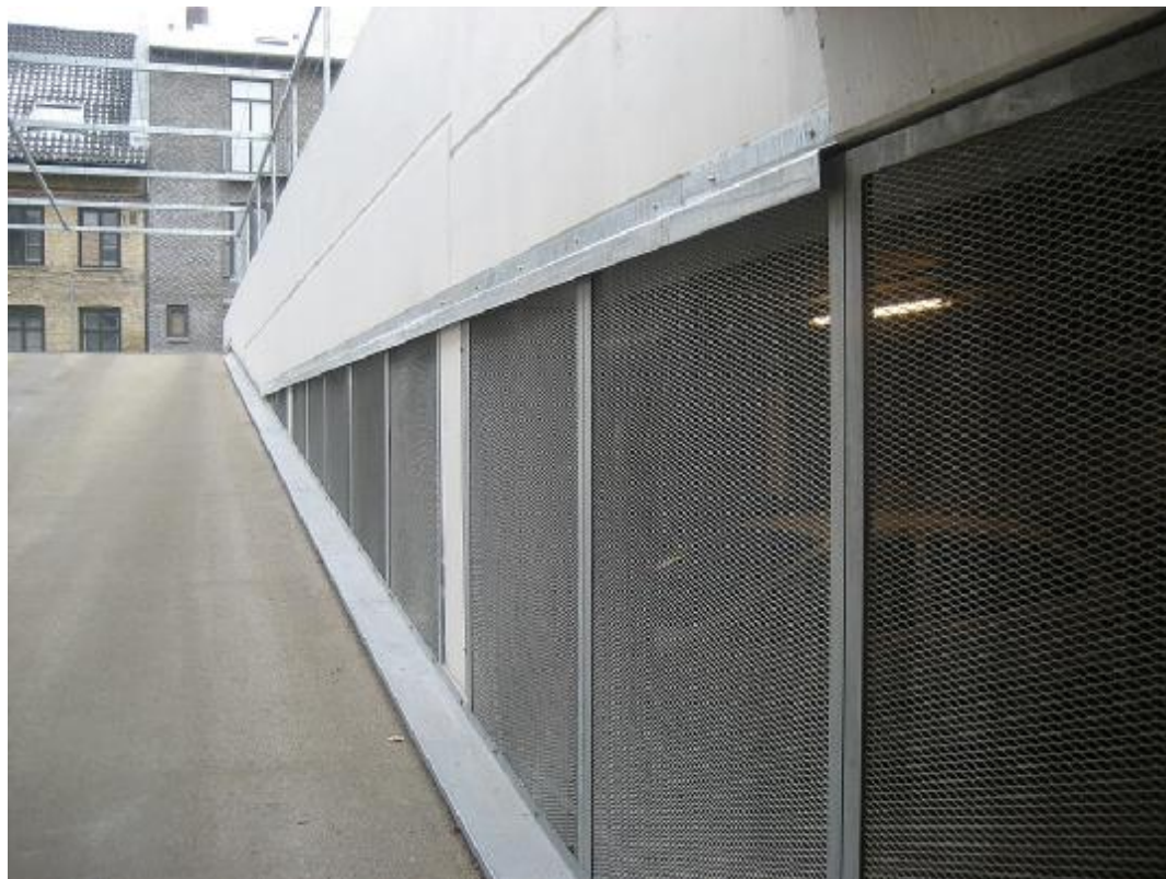
Etablering af drypnæse på betonkant over rammer med strækmetal
