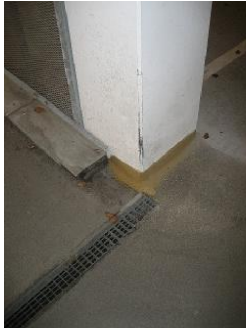
Epoxy behandling omkring betonsøjle ved ACU-dræn
