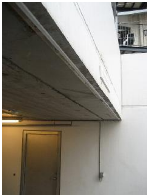
Drypnæse på betonbjælke over foldeport
