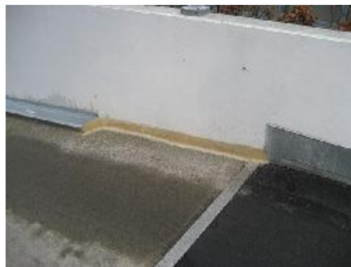
Epoxy behandling af betonkant ved top af nedkørselsrampe (højre side)
