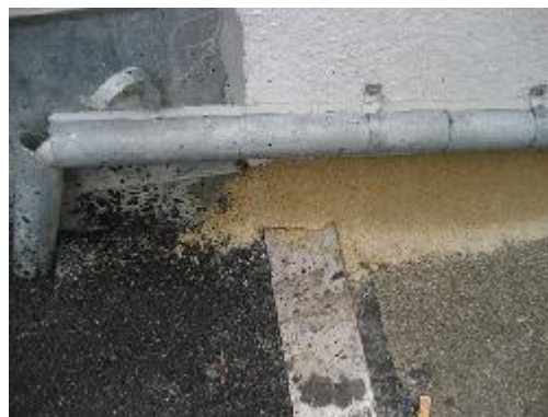
Epoxy behandling af betonkant ved top af nedkørselsrampe (venstre side)
