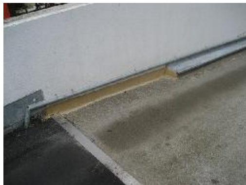
Epoxy behandling af betonkant ved top af nedkørselsrampe (venstre side)
