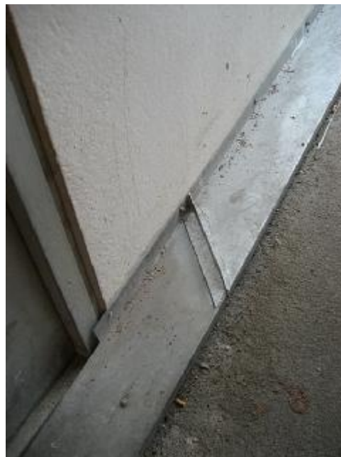
Genmontage af opkant på afvandingsprofil foran dør til vicevært
