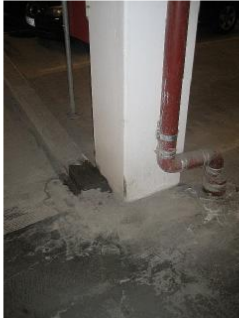
Fugtplet på gulv ved søjle ved fod af rampe ved p-dæk -2
