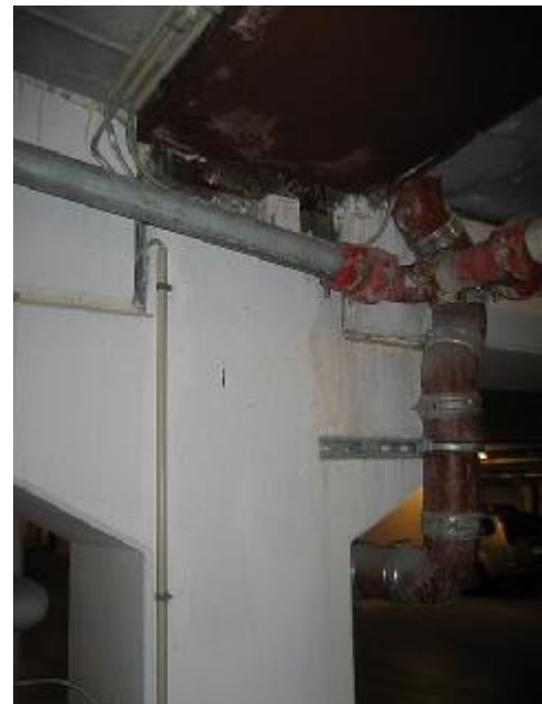
Vandindtrængen ved loft over søjle ved fod af rampe ved p-dæk -2
