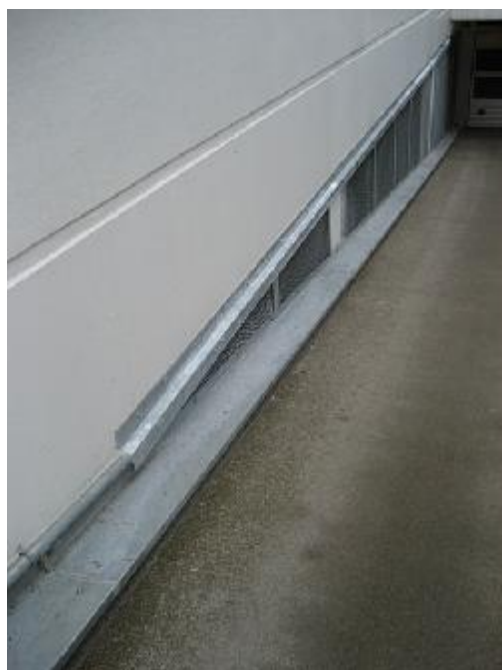
Etablering af drypnæse på betonkant over rammer med strækmetal (der er fuget mellem profil og betonkant samt bag rør).
