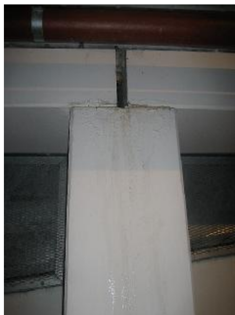
Synlig vandindtrængen på inderside drager
