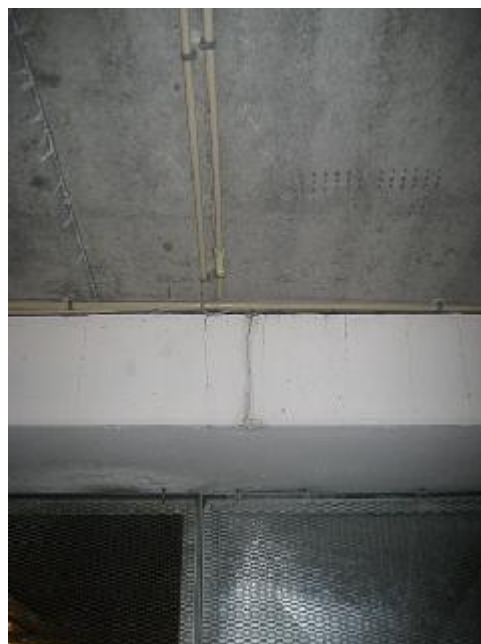
Synlig vandindrængen på inderside drager
