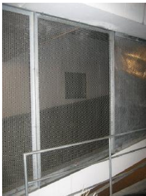
Synlig vandindrængen over ikke lukket ramme (ved betonbjælke over port)
