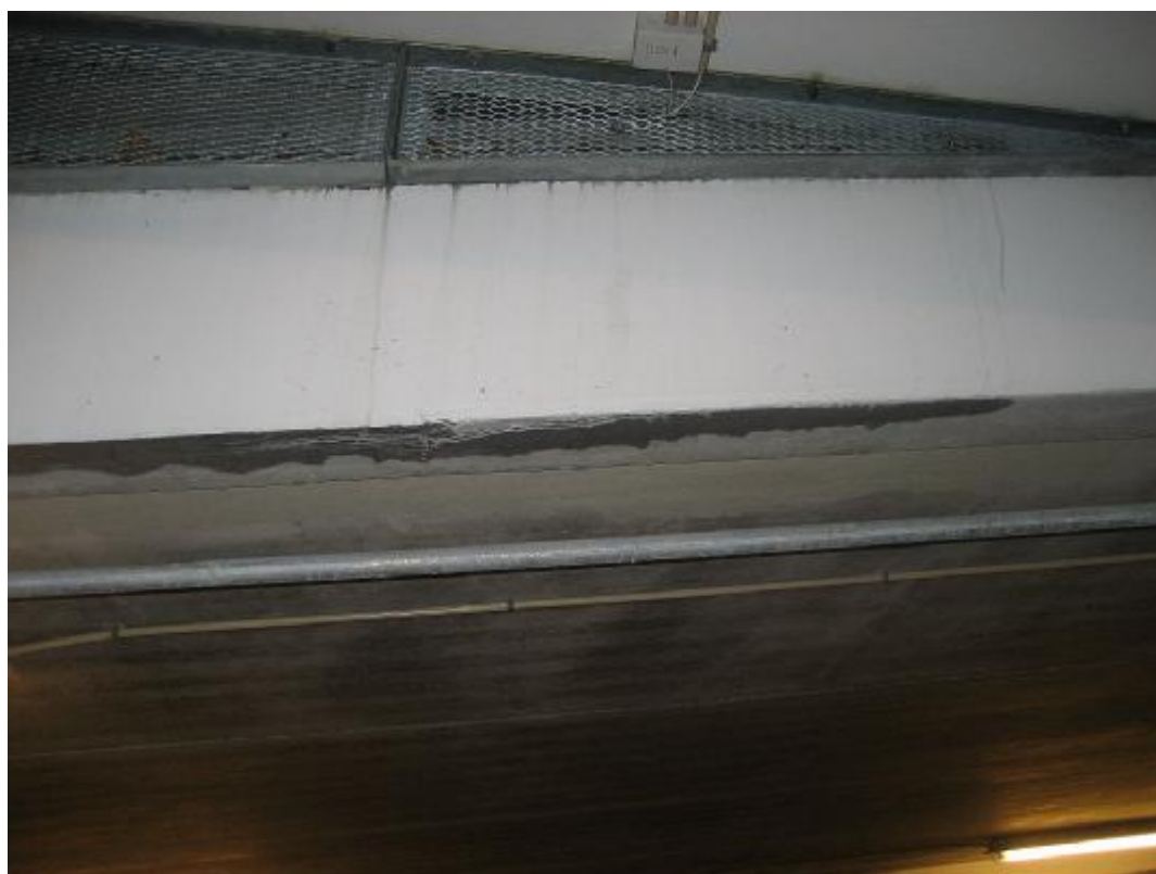
Synlig vandindtrængen ved rampens frie kant. Øverste felt er ikke dækket med lukket plade.
