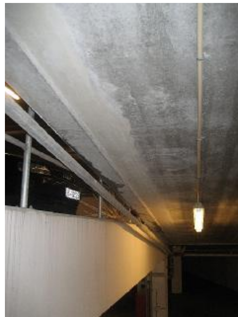
Synlig vandindtrængen. (Underside rampe fra terræn til p-dæk -1)
