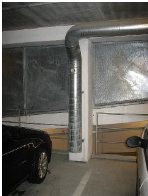
Synlig vandindtrængen ved søjle på P-dæk-1
