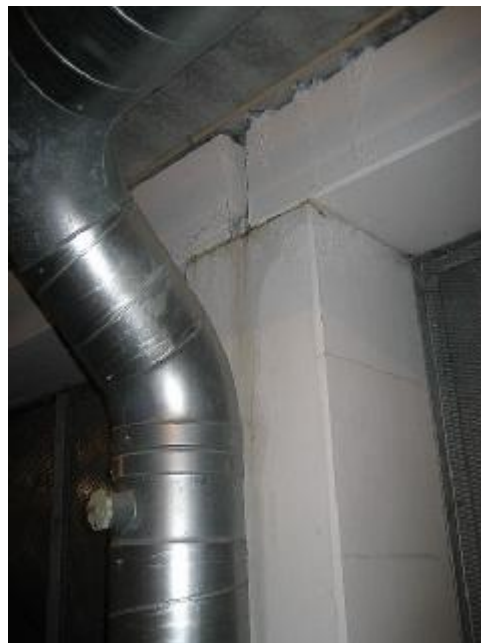
Synlig vandindtrængen på inderside drager
