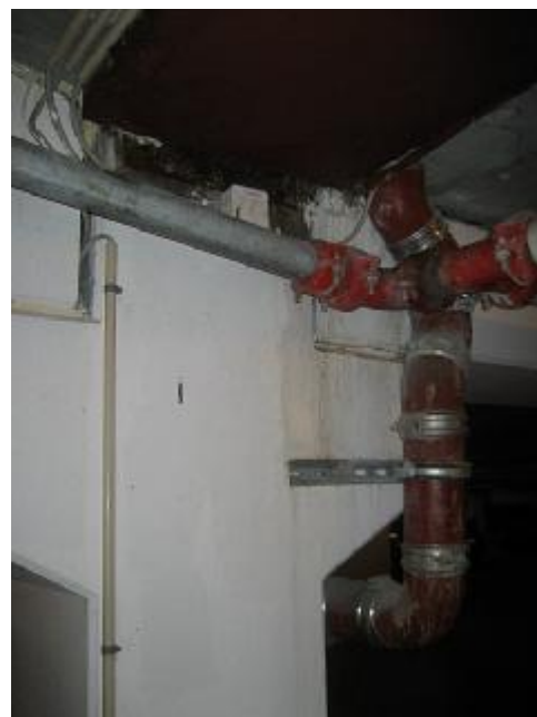
Synlig vandindtrængen i form af løbende vand
