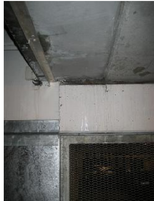
Nederste felter er bibeholdt åbne. Der kan observeres vandindtrængen mellem dæk og overliggende drager.
