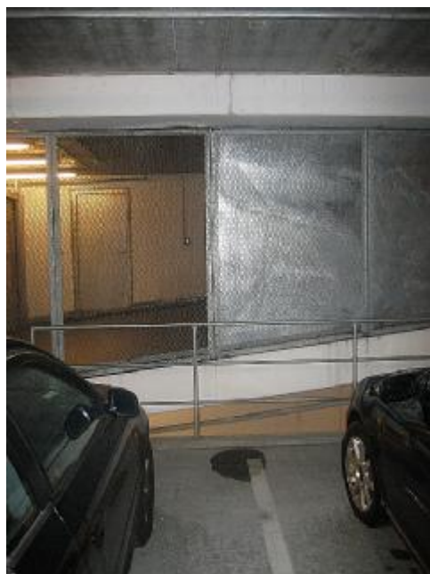
Fugtplet på P-dæk-1 (ved port).
