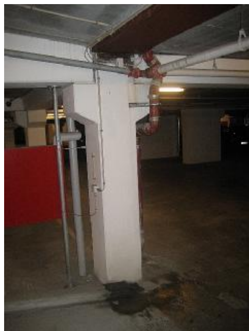
Vandindtrængen ved loft over søjle ved fod af rampe ved p-dæk -2
