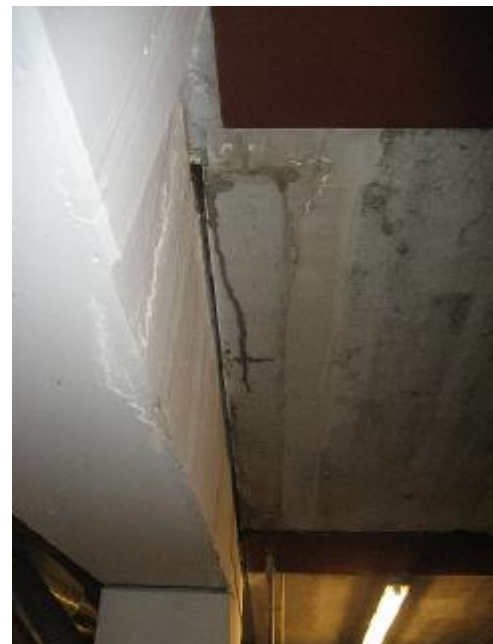
Vandindtrængen ved øverste bærejern.
