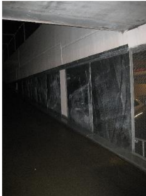
Udført lukning med plader popnippet på rammer med strækmetal. (rampe fra terræn til P-dæk-1)
