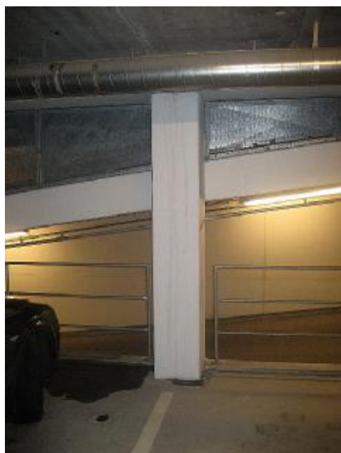
Synlig vandindtrængen ved søjle på P-dæk-1
