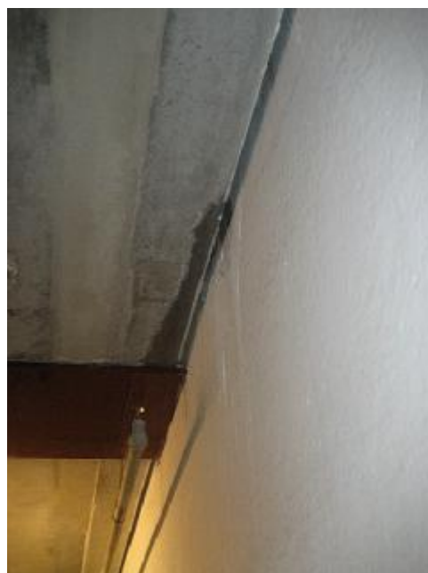
Synlig vandindtrængen ved underside dæk
