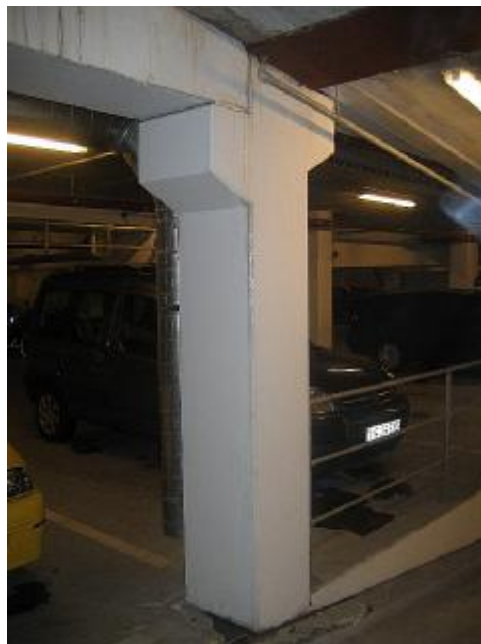
Søjle ved rampe ml. P-dæk-1 og P-dæk-2
