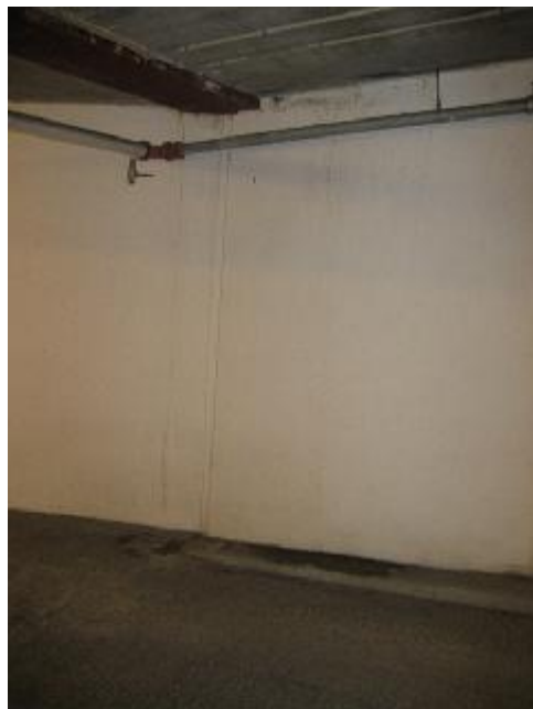
Synlig vand ved rampefod til på dæk -2.
