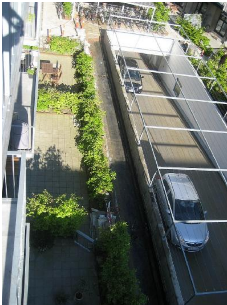
Opgravning af gangareal langs rampens venstre side – 13.5
