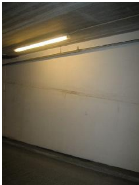
Synlig vand på rampekant (gulv) ml. dæk -1 og -2
