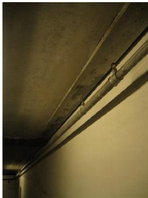
Synlig vandindtrængen ved underside dæk ml. dæk -1 og -2
