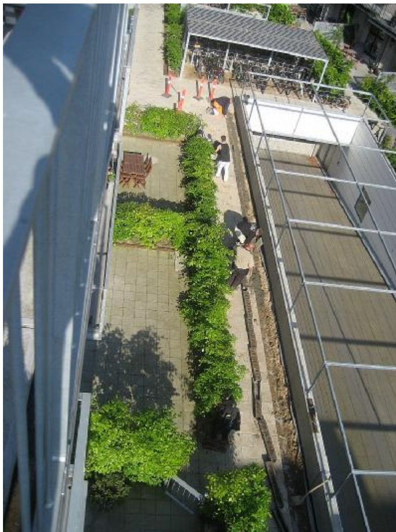
Reetablering af fliser og afløbsrende – 19.5
