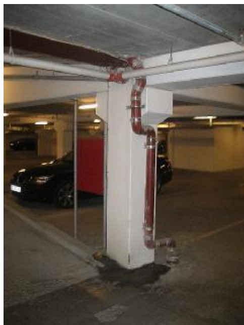
Vandindtrængen ved loft over søjle ved rampefod på dæk -2
