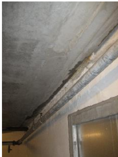
Synlig vandindtrængen ved underside dæk. ved rampefod til dæk -2
