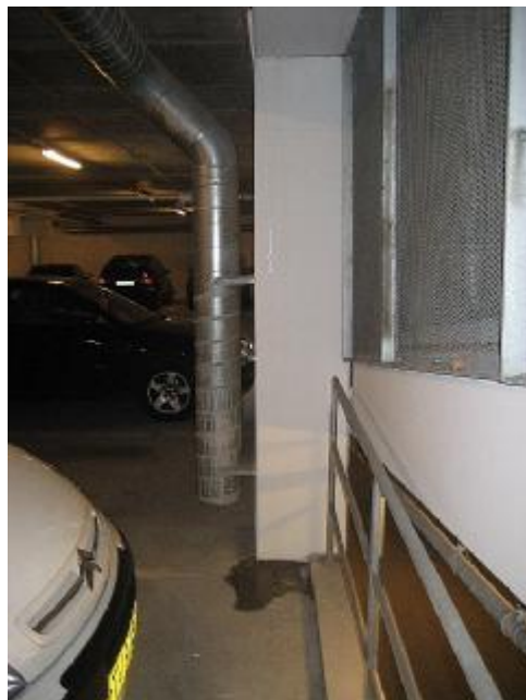
Synlig vandindtrængen langs søjle
