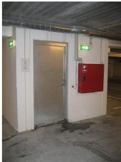
Vandindtrængen ved dør på dæk -3
