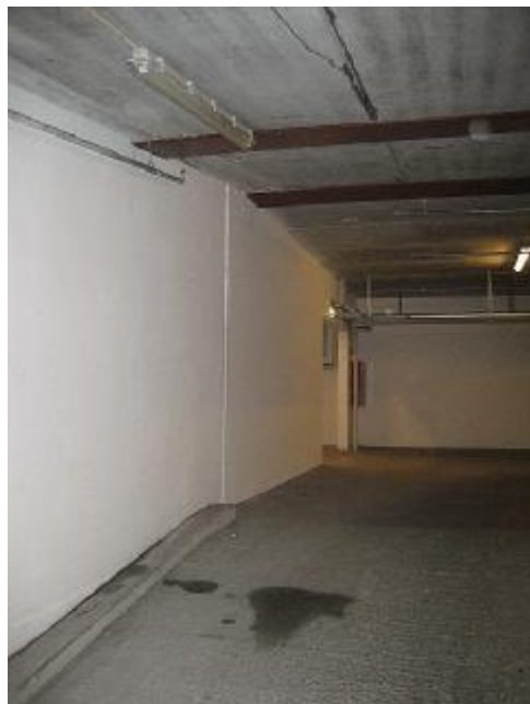
Vandindtrængen ved væg langs rampe (under nedkørselsrampens højre side)
