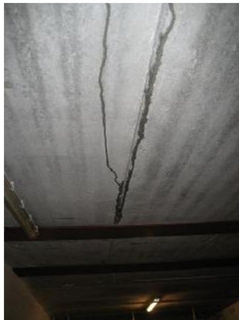
Vandindtrængen midt på rampens underside
