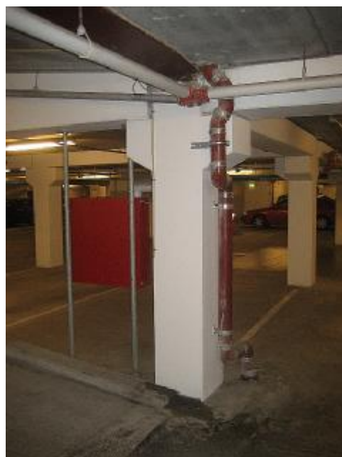
Synlig vandindtrængen ved søjle på dæk -2 (under vandrende ved port)
