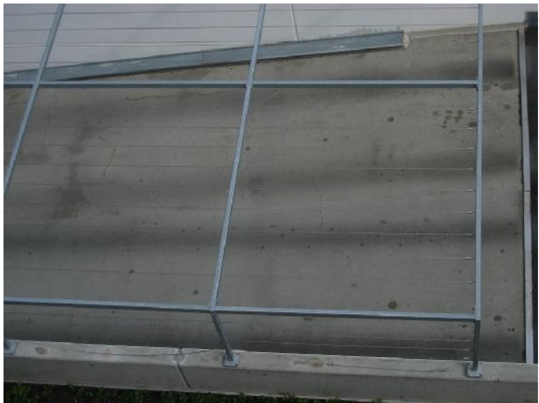
Revnedannelse i top-coating på øverste kørerampe
