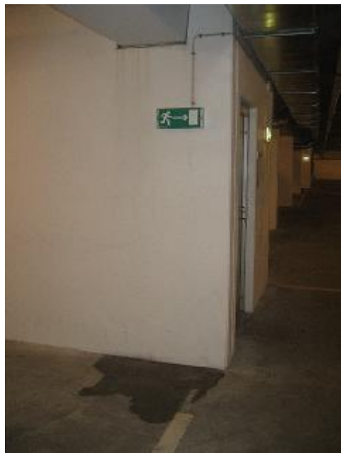
Vandindtrængen ved bjælke, højre side (på dæk -1)
