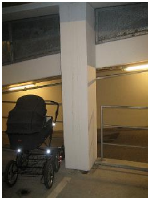
Synlig vandindtrængen langs søjle
