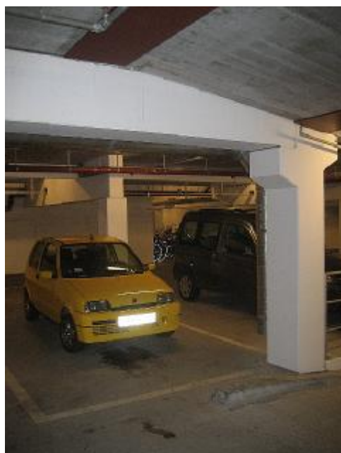
Synlig vandindtrængen ved øverste bæreprøfil (dæk -1)
