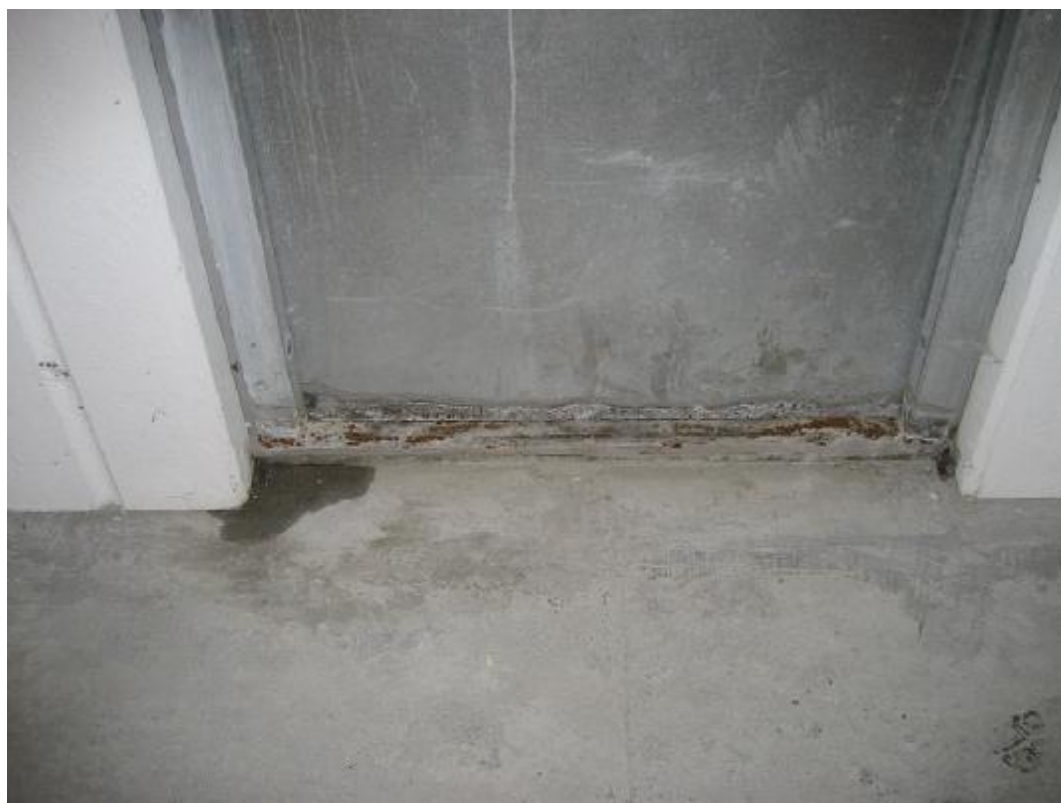
Dør og dørtrin på dæk -3 udviser store korrosioner.
