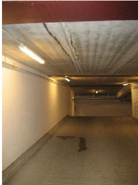
Vandindrængen midt på rampens underside
