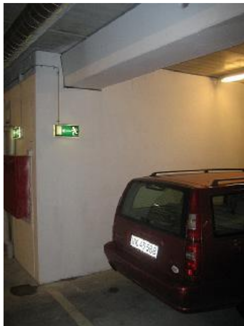
Vandindtrængen ved bjælke og øverst på vægside på dæk-1
