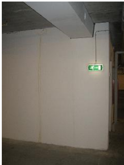
Vandindtrængen øverst på vægside mod øst (dæk -1)
