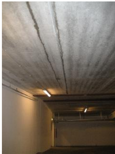
Vandindtrængen midt på rampens underside
