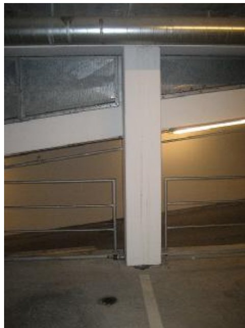
Synlig vandindtrængen langs søjle
