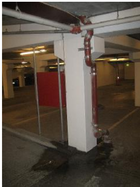
Vandindrængen ved søjle ved rist i port (dæk -2)
