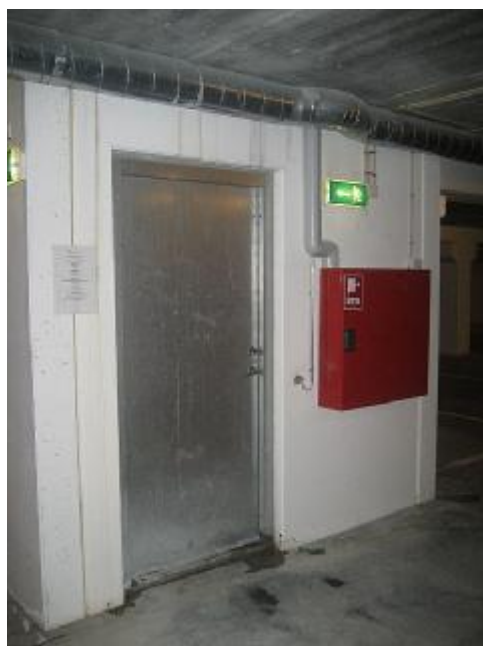
Vandindtrængen over dør (dæk -3)
