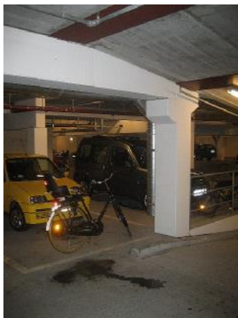
Synlig vandindtrængen ved øverste bæreprøfil (dæk -1)
