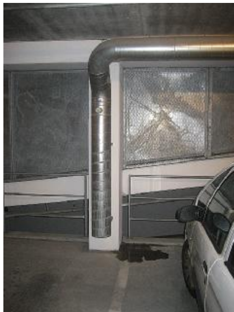
Synlig vandindtrængen langs søjle
