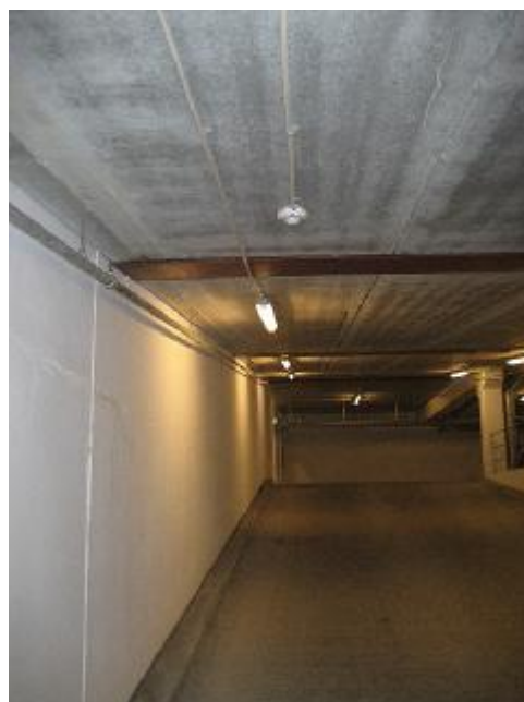
Vandindtrængen midt på rampens underside
