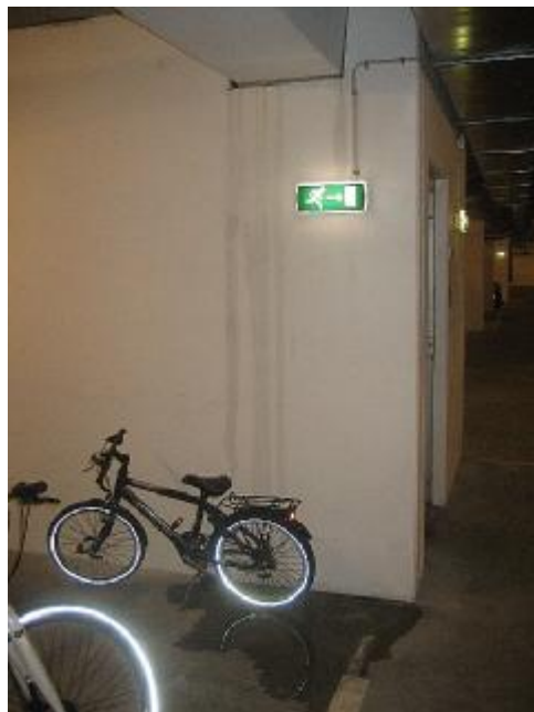
Vandindtrængen ved bjælke, højre side (dæk -1)
