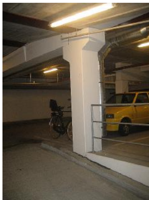
Synlig vandindtrængen ved øverste bæreprøfil (dæk -1)
