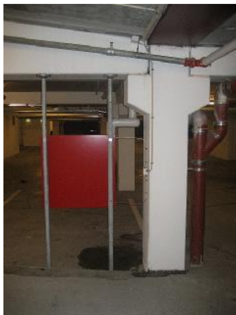
Vandindrængen ved søjle ved rist i port (dæk -3)
