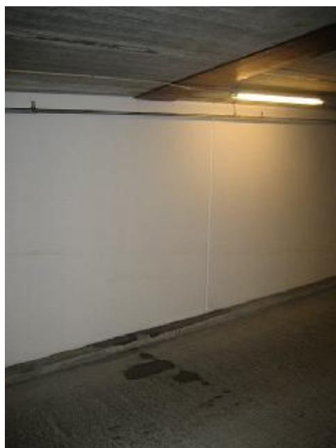
Vandindtrængen midt på væg langs rampe (under nedkørselsrampens højre side)
