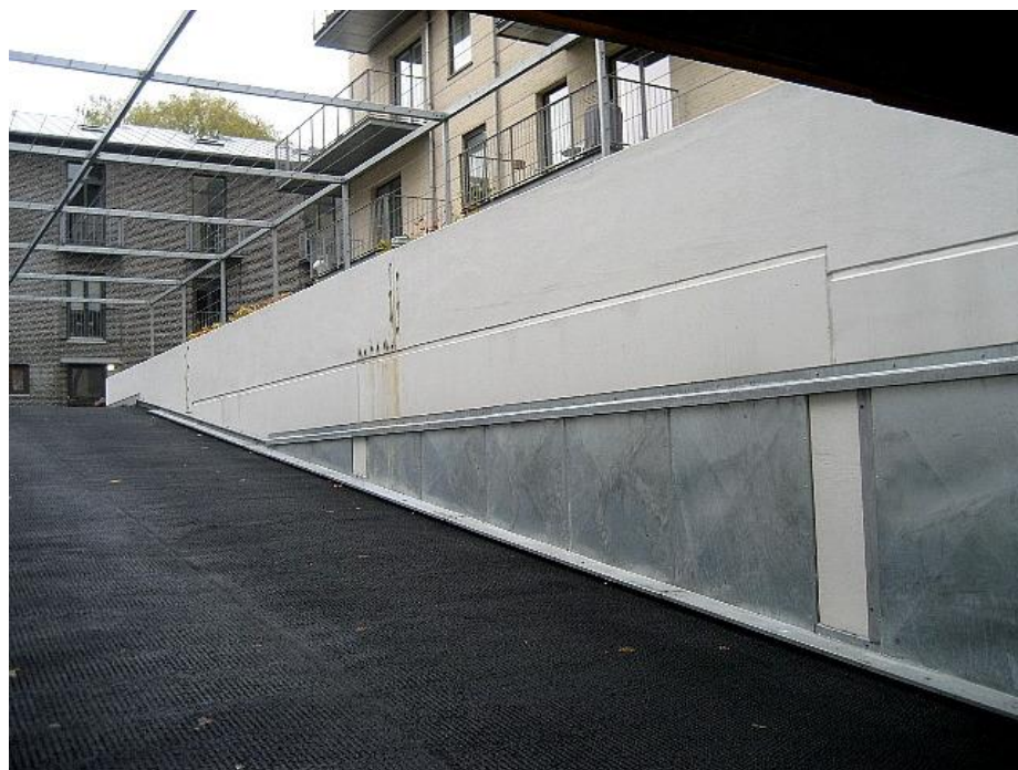
24.10 – Udbedringsarbejder ved inddækninger er udført
