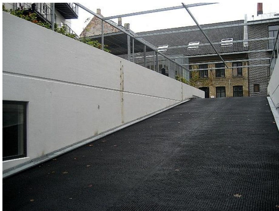
24.10 – Udbedringsarbejder ved inddækninger er udført
