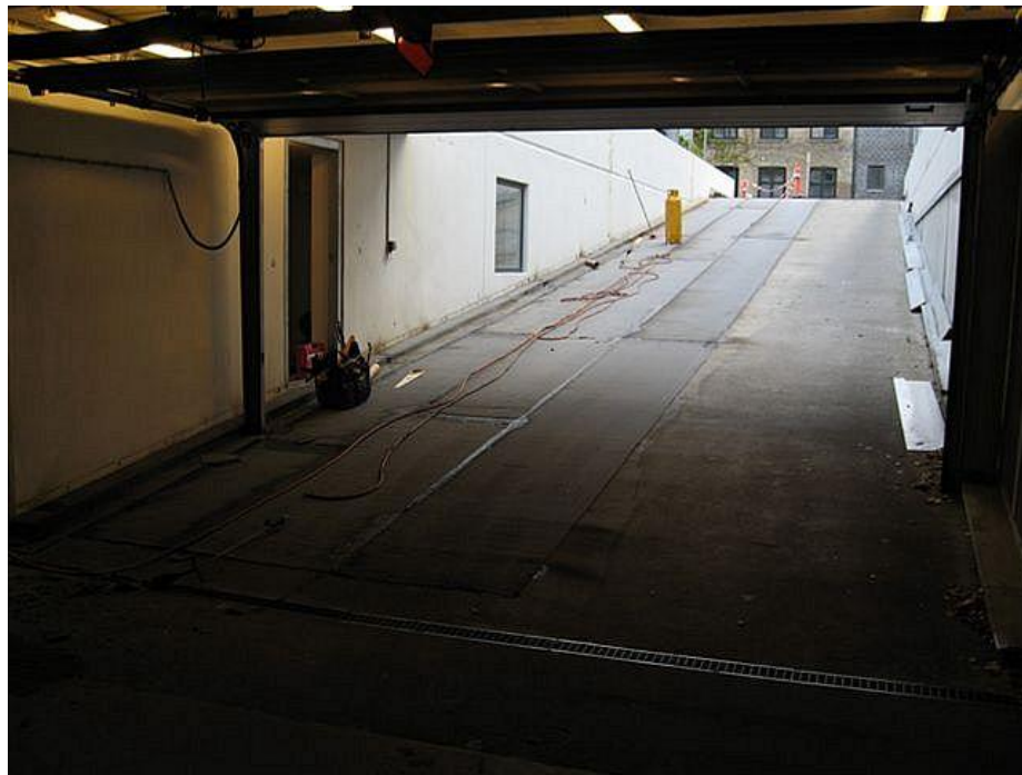
13.10 – Udlægning og fastsvejsning af ny membran (asfaltpap) (MNJ Observation)
