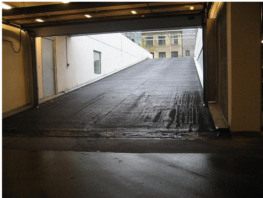
24.10 – Arbejder ved rist er udført (HI Observation)
