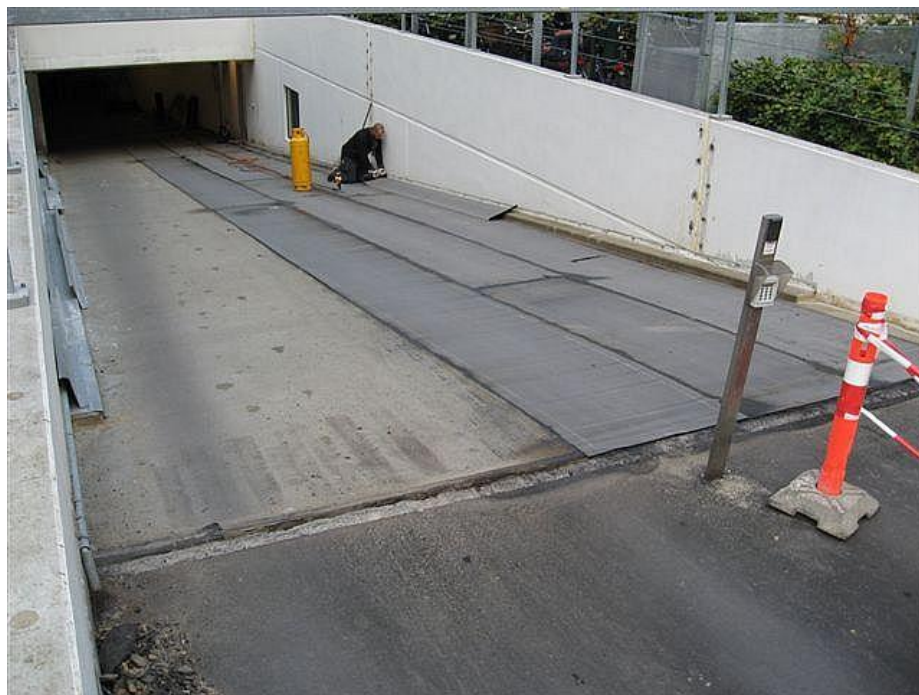
13.10 – Udlægning og fastsvejsning af ny membran (asfaltpap)
