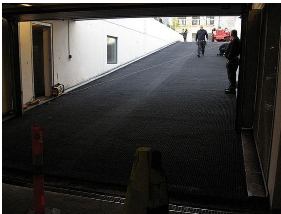
15.10 – Udlægning af ny topbelægning (støbeasfalt – pigrullet)
