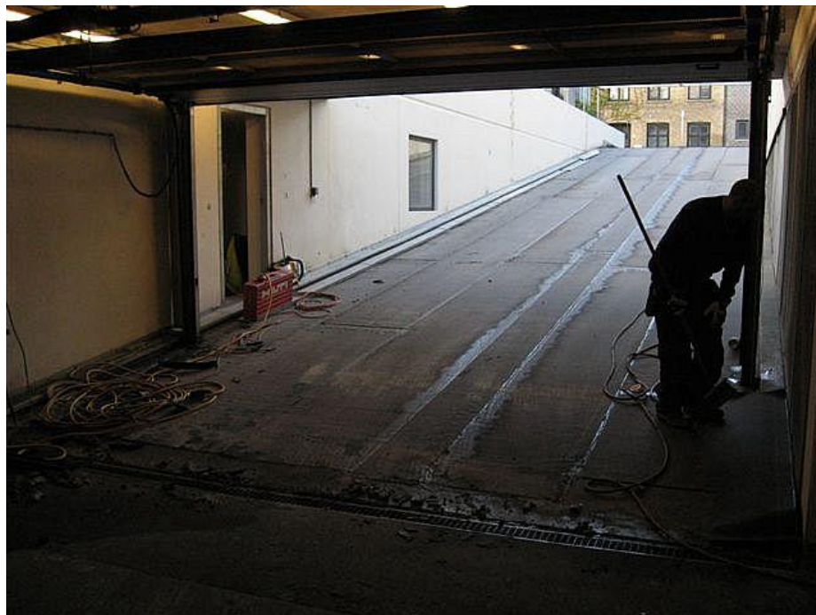
14.10 – Udlægning og fastsvejsning af ny membran (asfaltpap) på hele rampen
