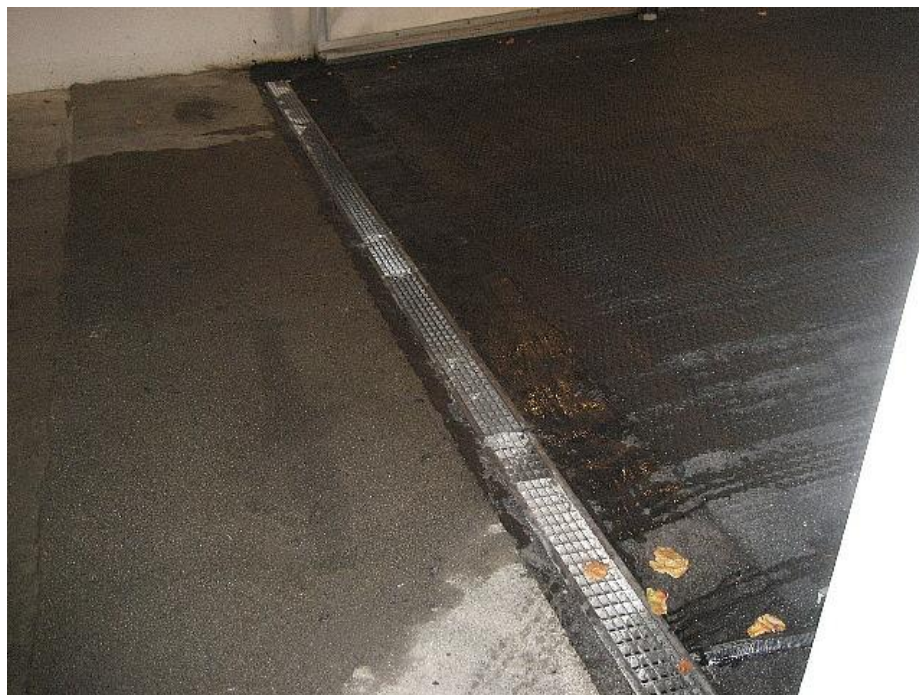
24.10 – Arbejder ved rist er udført
