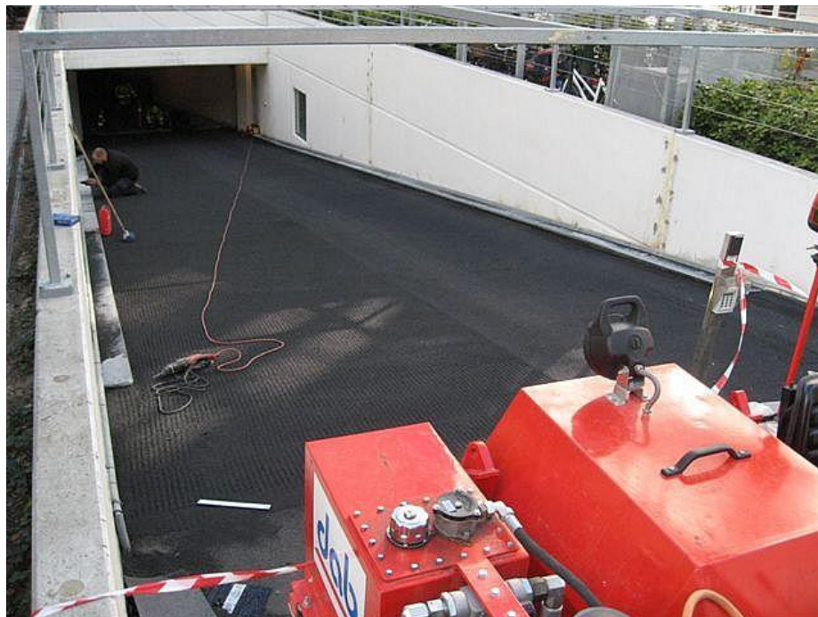
15.10 – Udlægning af ny topbelægning (støbeasfalt – pigrullet)
