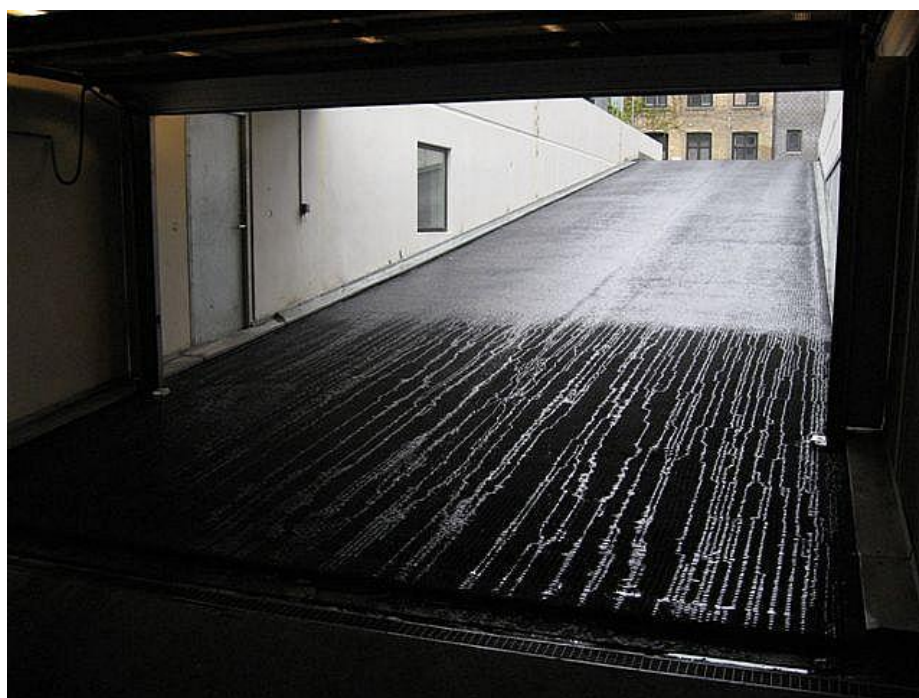
16.10 – Ny topbelægning er udført – arbejder ved rist pågår.
