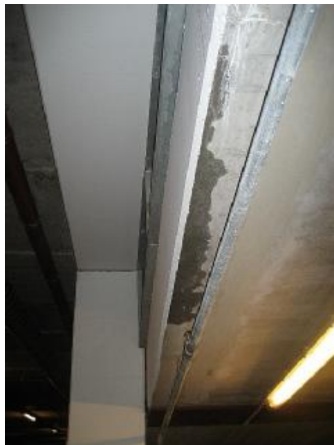
Vandindtrængen ved rampens frie side (dæk -1)
