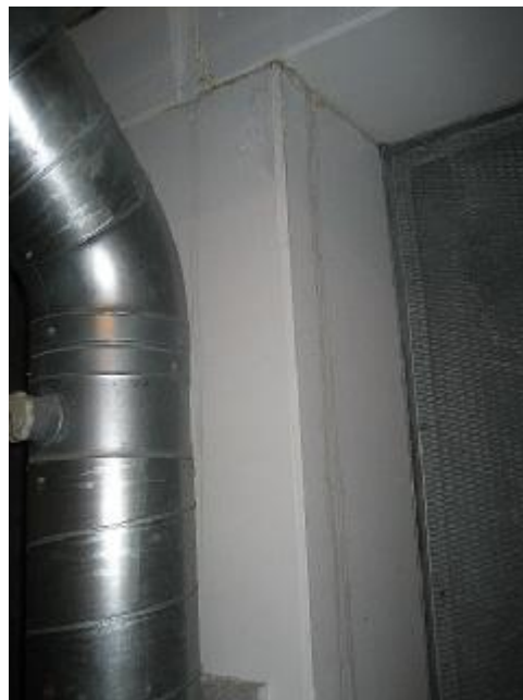
Synlig vandindtrængen langs søjle (dæk -1)
