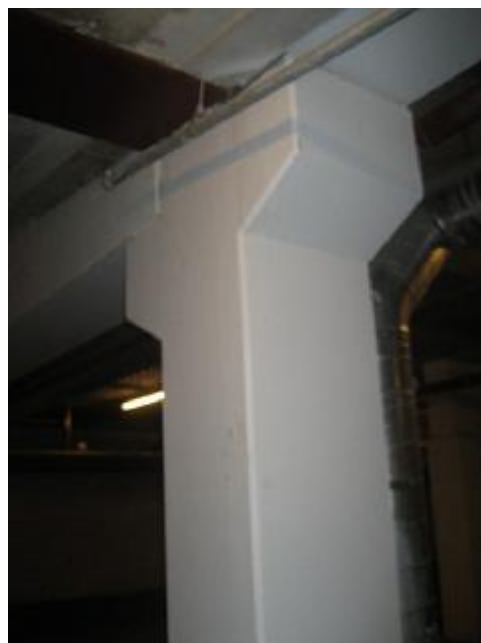
Synlig vandindtrængen ved øverste bæreprøfil (dæk -1)
