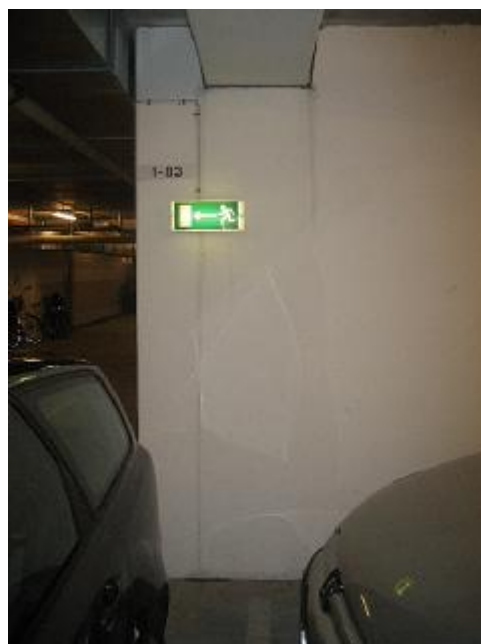
Vandindtrængen ved bjælke, vægside mod vest (dæk -1) – 25.10
