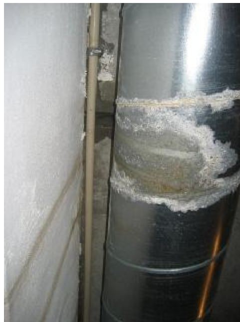
Vandindtrængen over dør (dæk -3)
