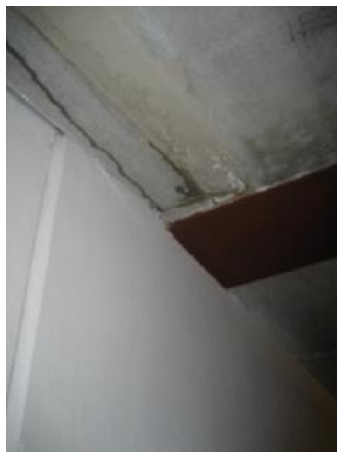
Vandindtrængen ved væg langs rampe
