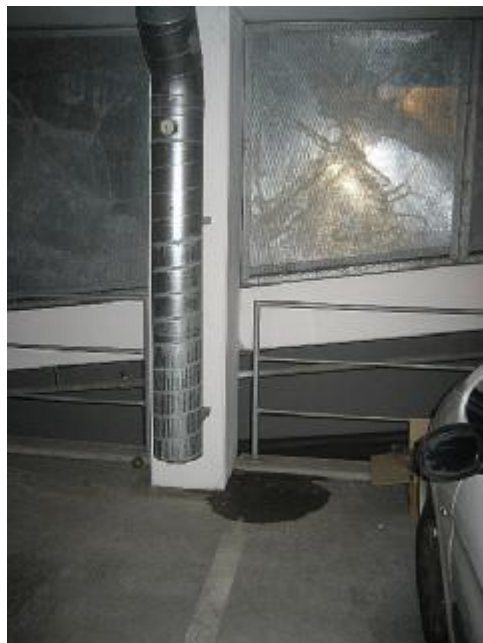
Synlig vandindtrængen langs søjle (dæk -1)
