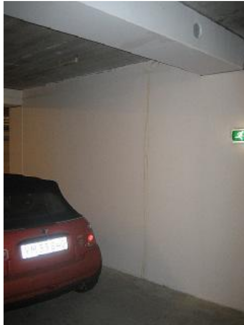
Vandindtrængen øverst på vægside mod øst (dæk -1) – 25.10
