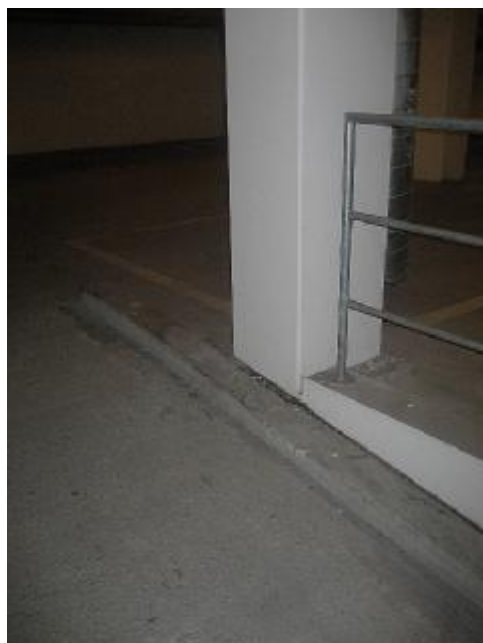
Synlig vandindtrængen ved øverste bæreprøfil (dæk -1)
