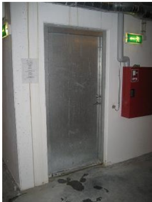
Vandindtrængen over dør (dæk -3)
