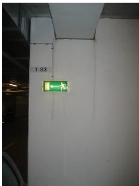
Vandindtrængen ved bjælke, vægside mod vest (dæk -1) – 24.10
