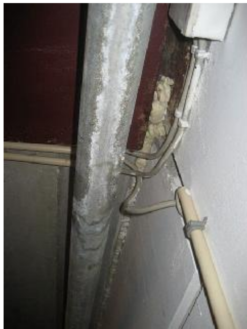
Vandindtrængen ved søjle ved rist i port (dæk -2)
