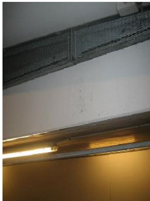
Vandindtrængen ved ved rampens frie side (dæk -1)
