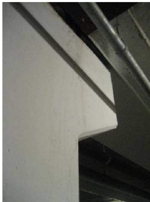
Synlig vandindtrængen ved øverste bæreprøfil (dæk -1)
