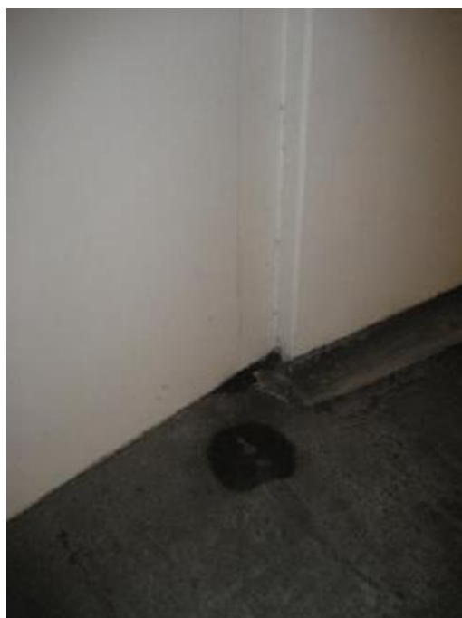
Vandindtrængen ved væg langs rampe (dæk -2)
