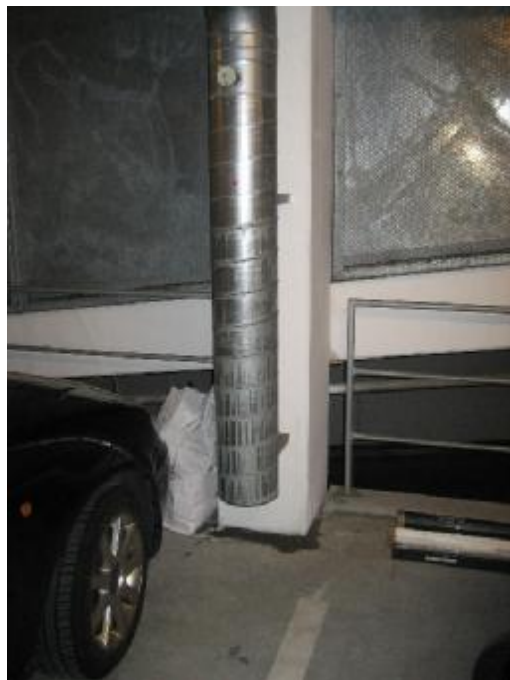
Synlig vandindtrængen langs søjle (dæk -1)
