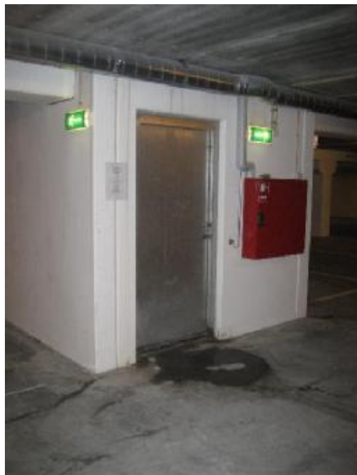
Vandindrængen ved dør (dæk -3)
