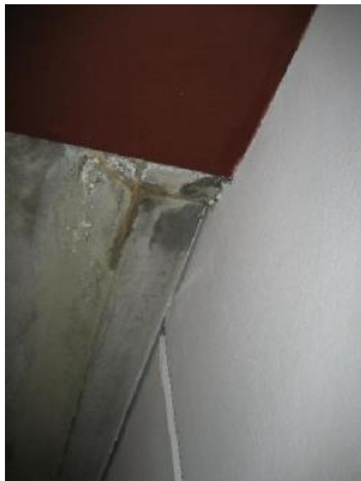
Vandindtrængen ved væg langs rampe (ved øverste bæreprøfil)
