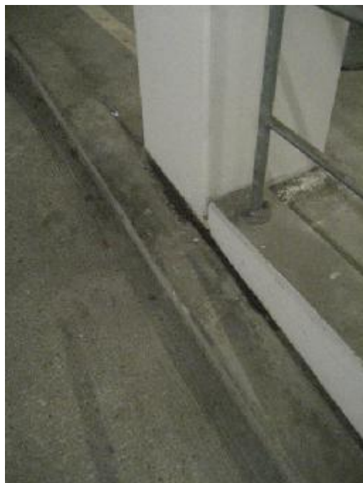
Synlig vandindtrængen ved øverste bæreprøfil (dæk -1)
