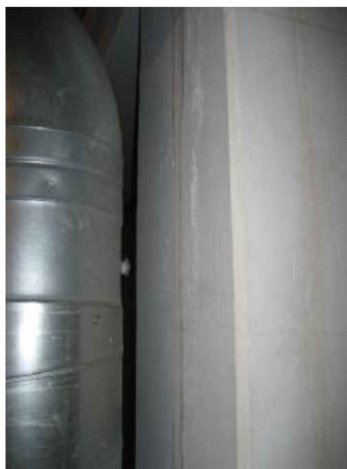
Synlig vandindtrængen langs søjle (dæk -1)
