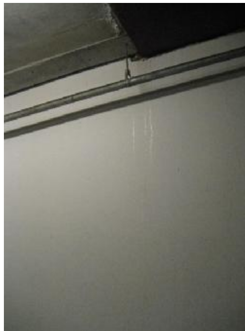
Vandindtrængen ved væg langs rampe
