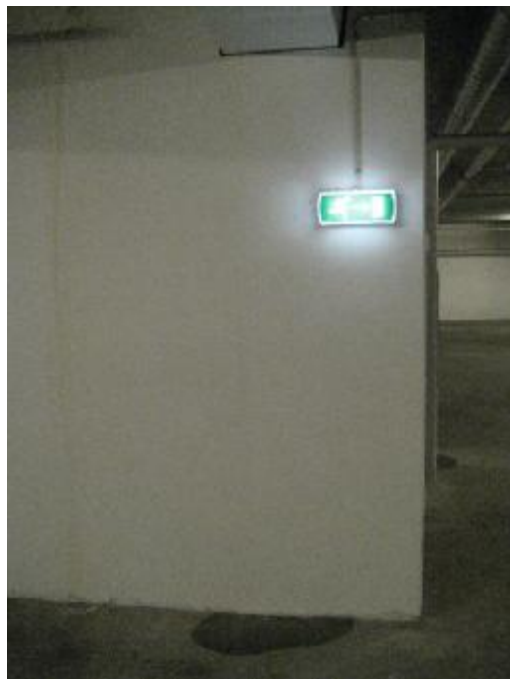
Vandindtrængen øverst på vægside mod øst (dæk -1)
