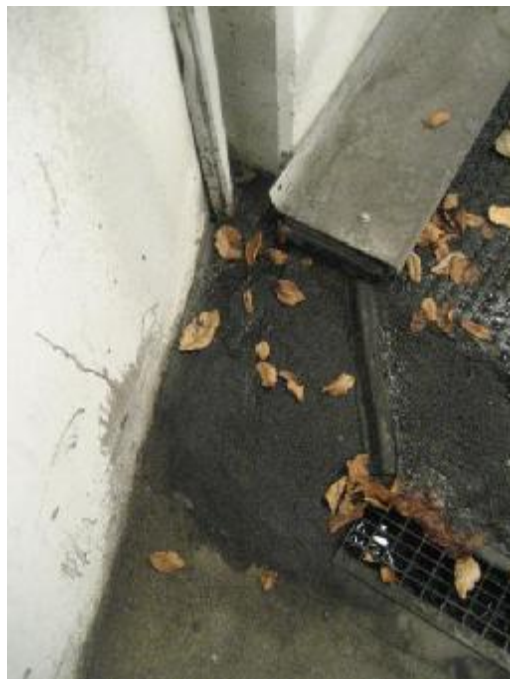
Vandsiven bag inddækningskant og skrå leder (dæk -1)
