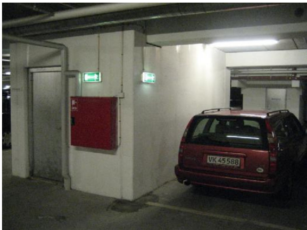
Vandindtrængen på vægside mod vest (dæk -1)
