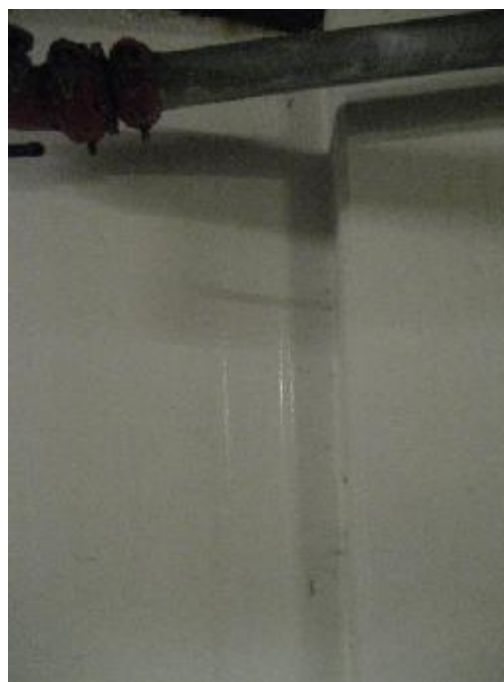
Vandindtrængen ved væg langs rampe (dæk -2)
