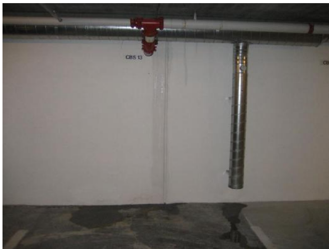
Vandindrængen langs bagvæg, fjernest fra rampe. (dæk -3)
