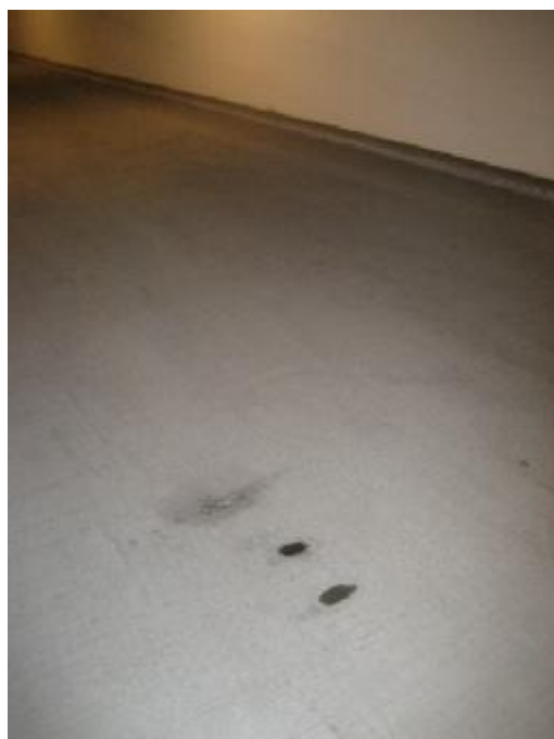
Vanddryp på rampedæk
