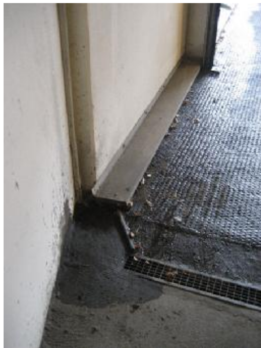
Vandsiven bag inddækningskant og skrå leder (dæk -1)
