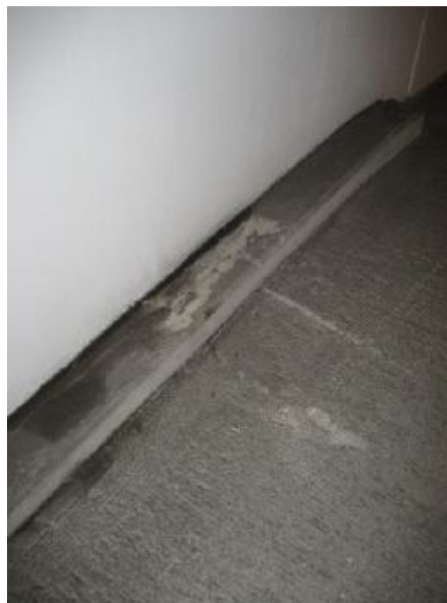
Vandindtrængen ved væg langs rampe
