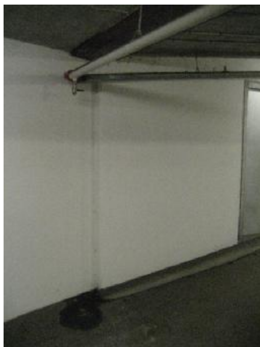
Vandindtrængen ved væg langs rampe (dæk -2)
