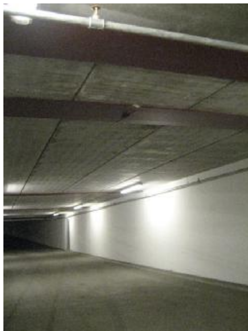
Vandindrængen ved mellemste bærejern
