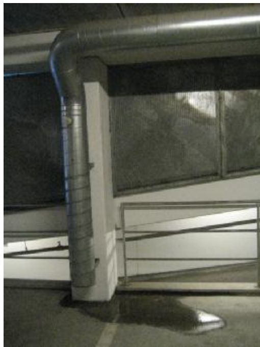
Synlig vandindtrængen langs søjle (dæk -1)
