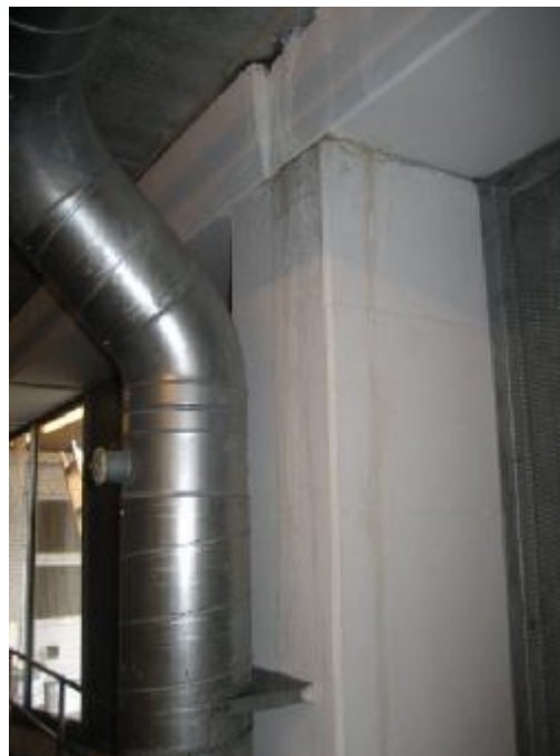
Synlig vandindtrængen langs søjle (dæk -1)
