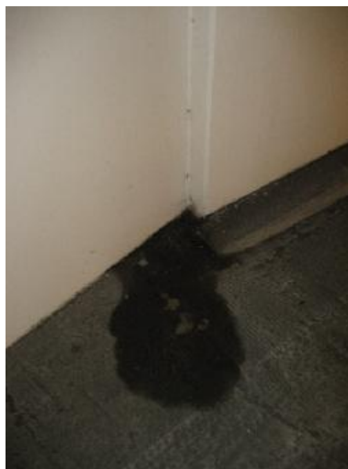
Vandindtrængen ved væg langs rampe (dæk -2)
